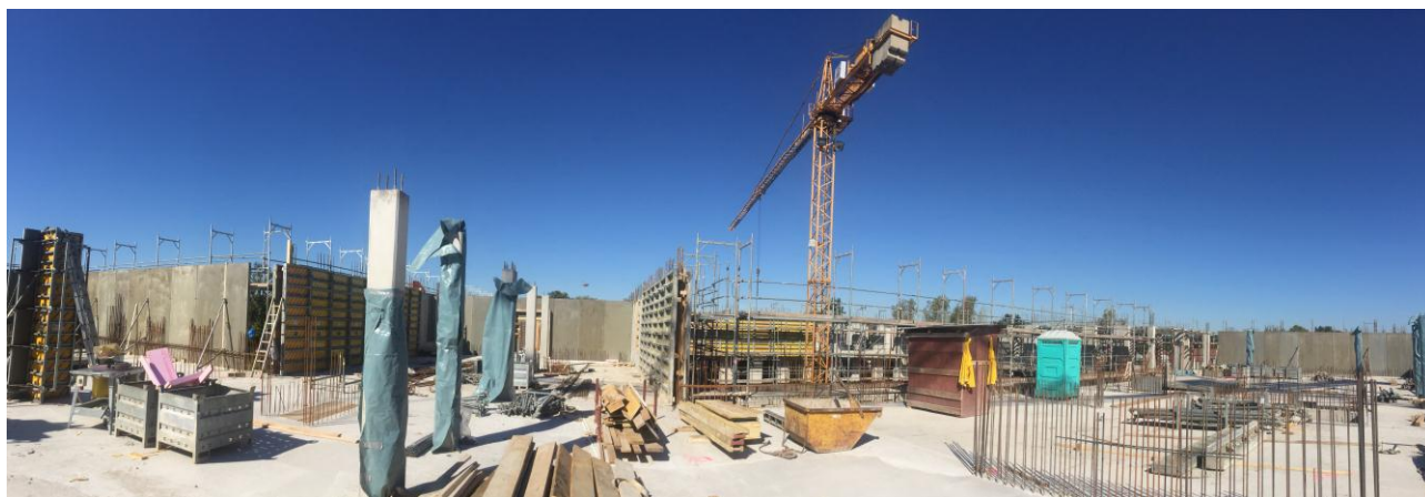
Wie man hier sieht, laufen die Restarbeiten in der 3. Etage mit Hochdruck. Foto Uwe Baumgart
