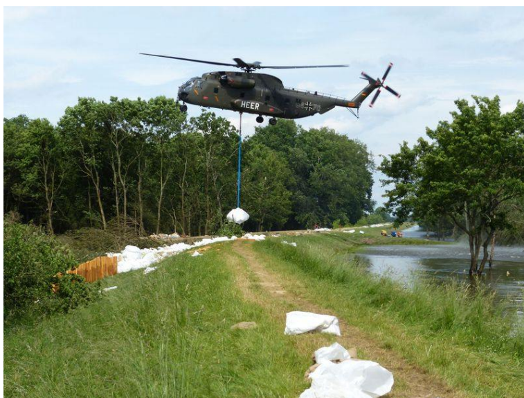
Deichwandverstärkung / rund 100 m wurden durch Bigpacks gesichert (Foto Kreisverwaltung)
