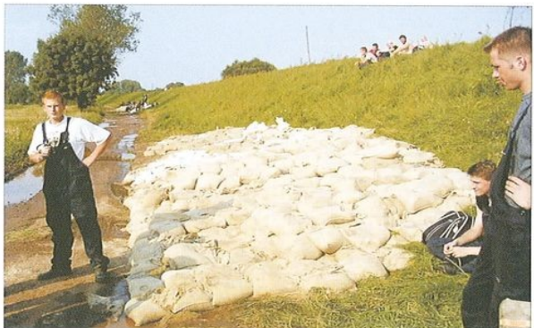
Fachgerechter Verbau von Sickerstellen am Elbedeich
