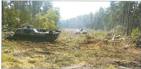
Die Schneise für den neuen Deichabschnitt am Treuel ist fertig
