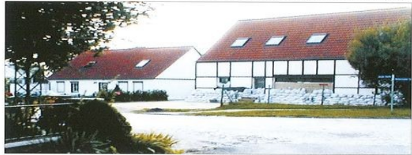
Sandsackverbau in Glindenberg
